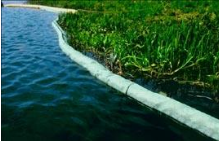
Рисунок 2.2.4.4 – Установка берегозащитных сорбирующих бонов
