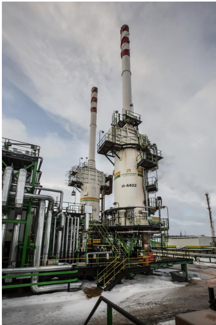
Рисунок 4.2-1 Фото печей подогрева (использовано фото из открытых источников)
